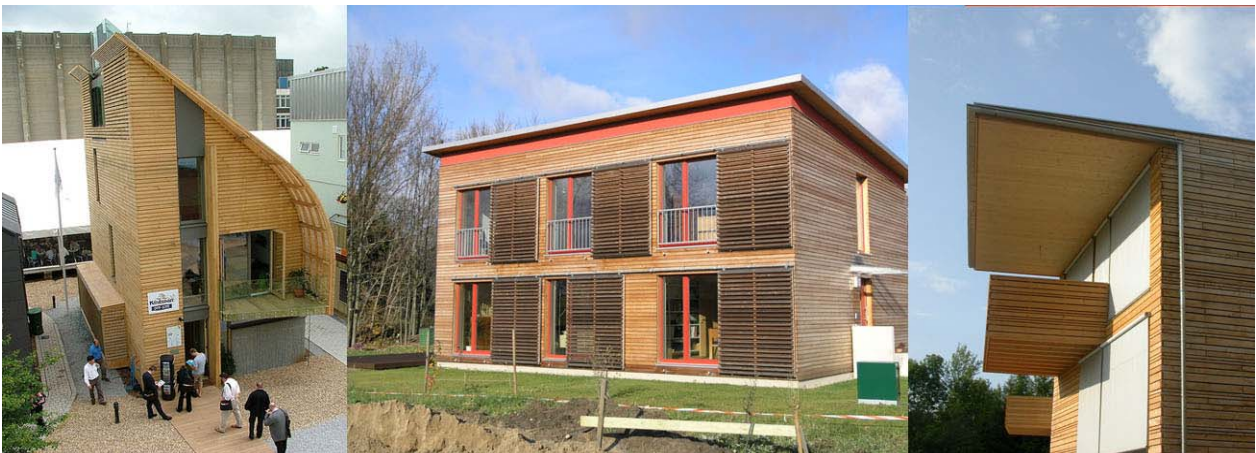
kuva: hiilineutraali omakotitalo Lighthouse Watfordissa (oik.), yksityisperheen passiivitalo Berliinin eteläpuolella (kesk.), arkkitehti, professori Walter Unterrainerin suunnittelema passiivipientalo Itävallassa (vas.); www.lowenergyhouse.com/zero-carbon-house.html ; Kimmo Lylykangas, Walter Unterrainer.
